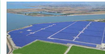
福岡県みやま市太陽光発電所
