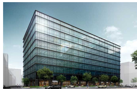
▲ 福岡市都心部の天神エリアで 開発したオフィスビル
