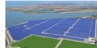
福岡県みやま市太陽光発電所
